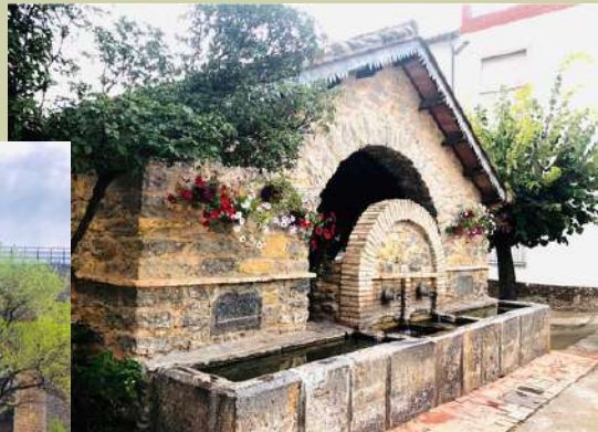
LAVADERO CALLE GAIBIEL
