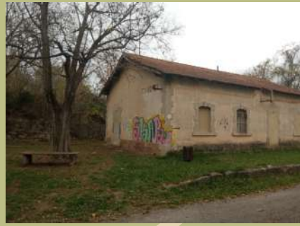
ANTIGUA ESTACIÓN MINERA
